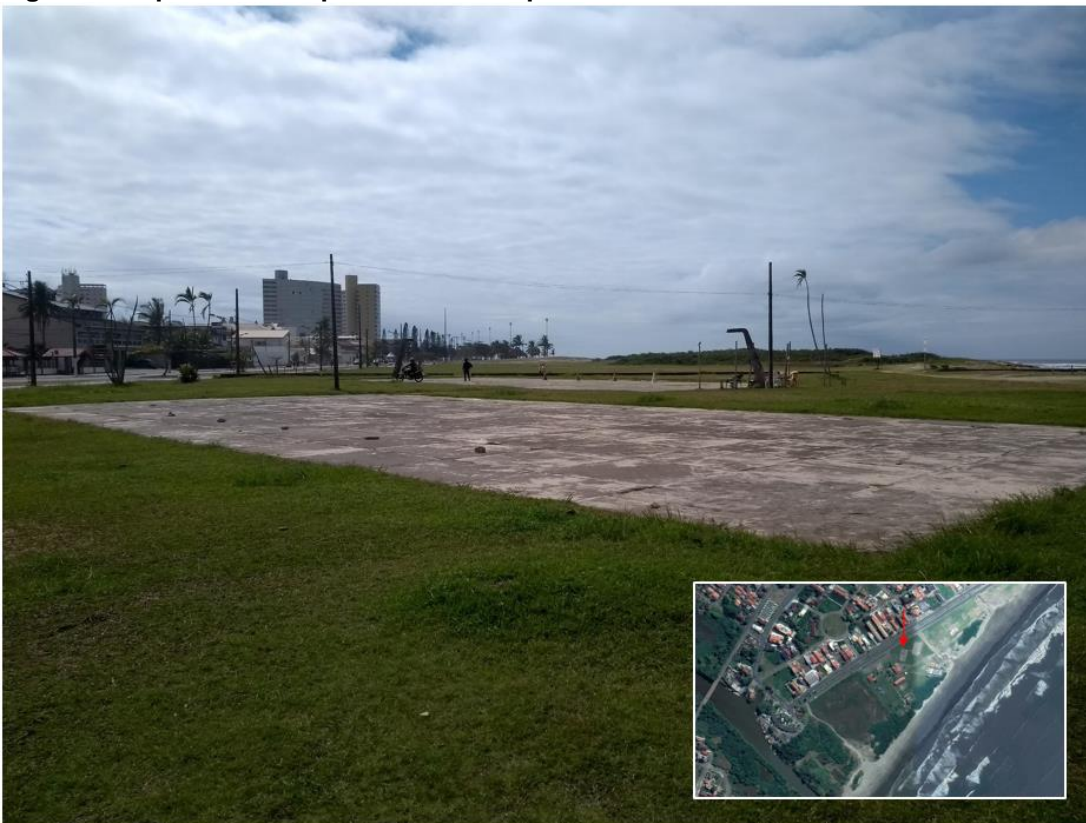
Figura 18 Pista de exame prático para motocicletas. Foto obtida por ocasião da vistoria realizada em 13/08/2018.
