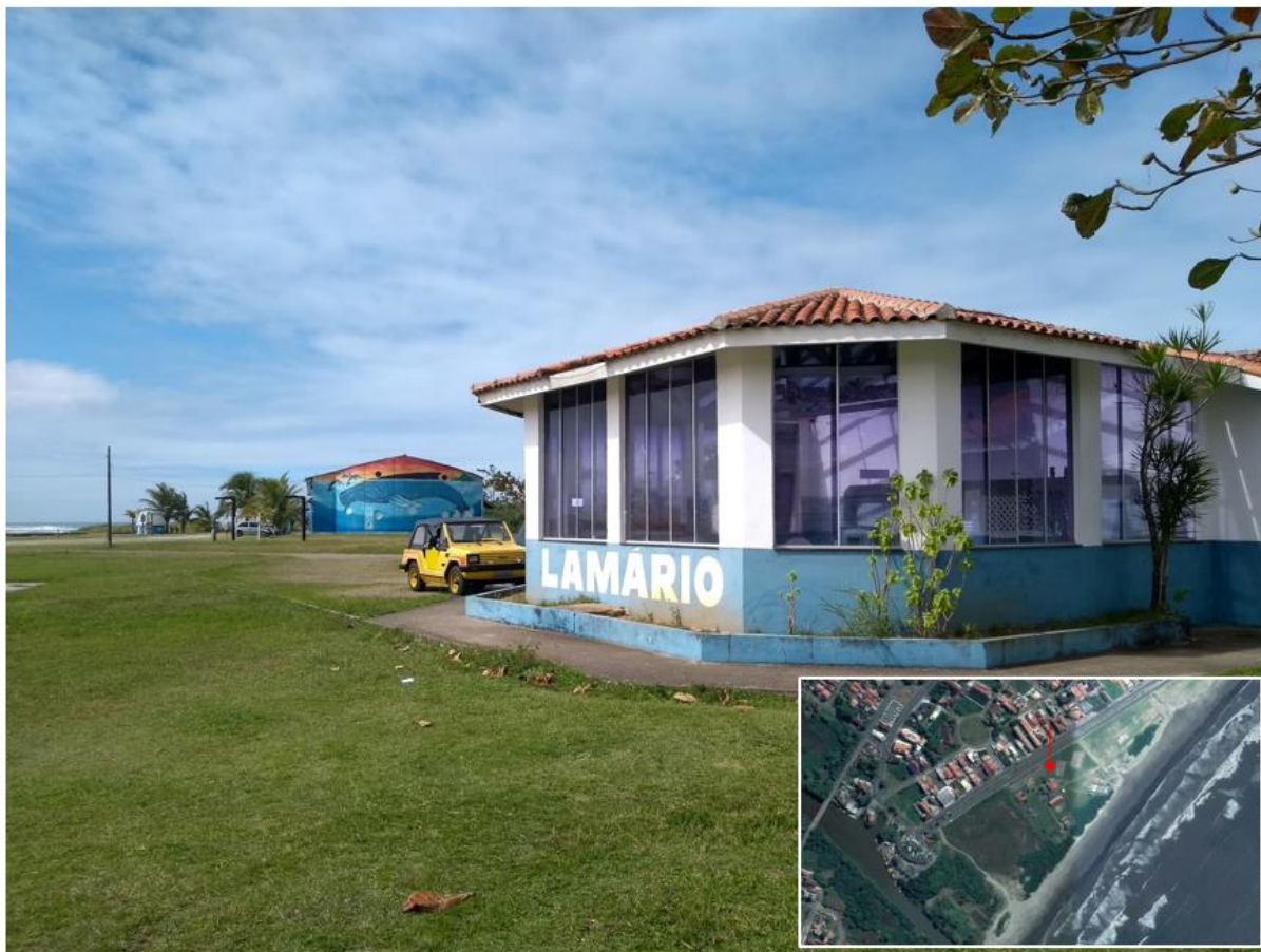
Figura 19 Lamário. Foto obtida por ocasião da vistoria realizada em 13/08/2018.
