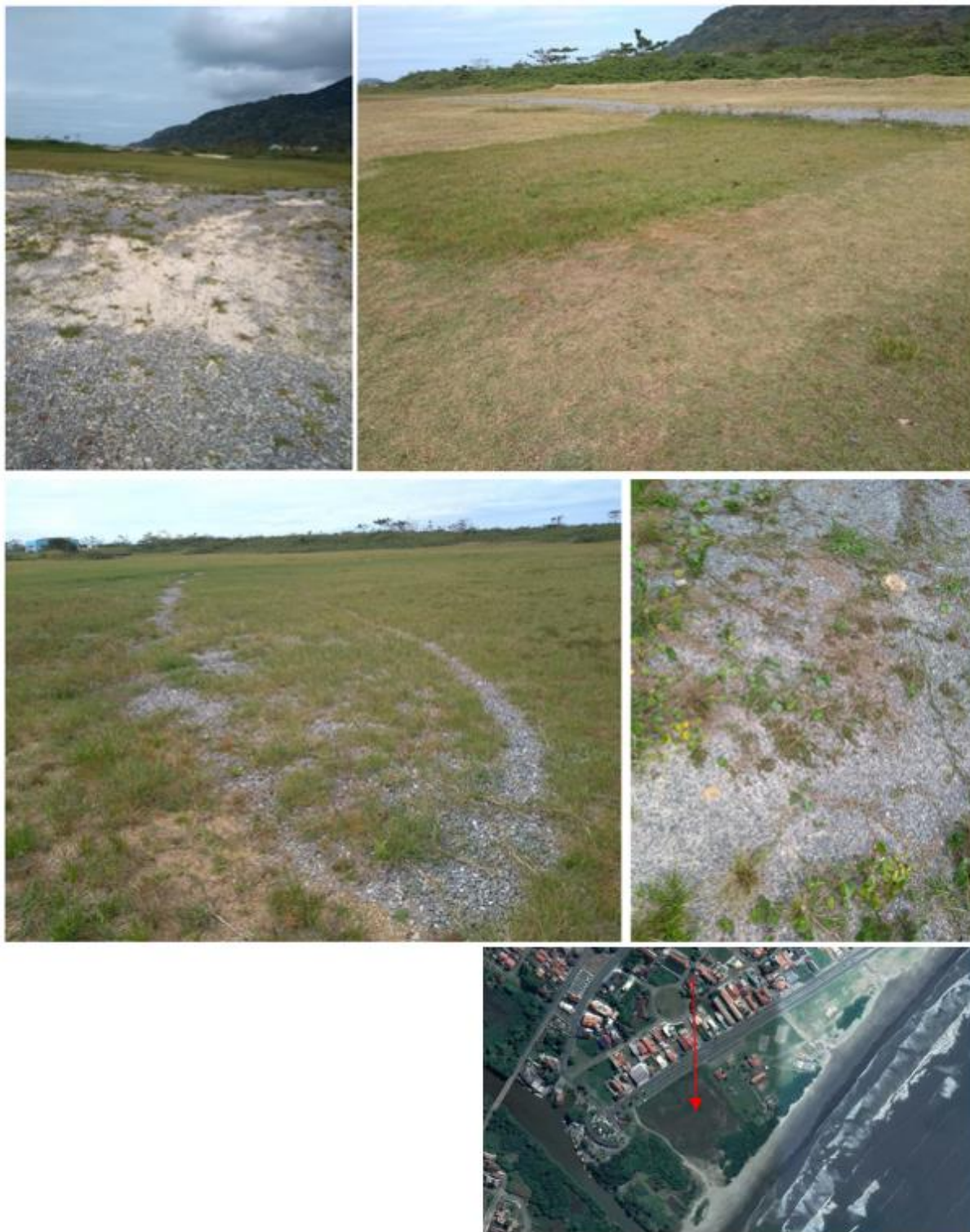
Figura 14 Deposição de britas em diversos pontos do terreno. Fotografia obtida por ocasião da vistoria realizada em 13/08/2018.
