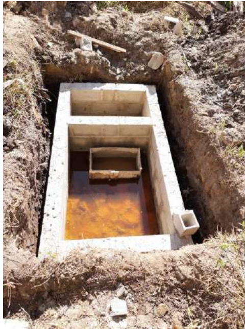
6. Instalação de fossa.
