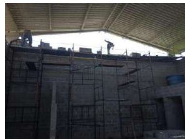
5. Demolição de estruturas danificadas e reconstrução de parede frontal (frente do terreno).
