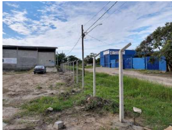
3. Cerca instalada na face frontal.
