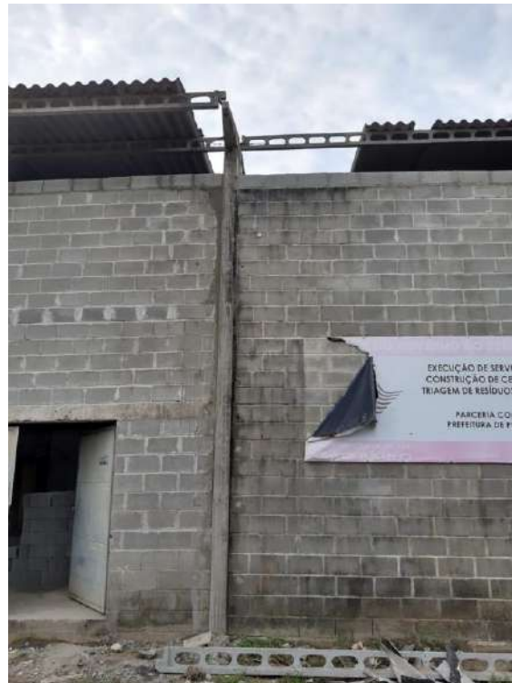
4. Troca de telhas e viga de concreto.
