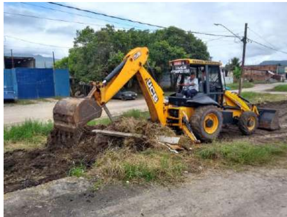
1. Início das obras, limpeza da área.
