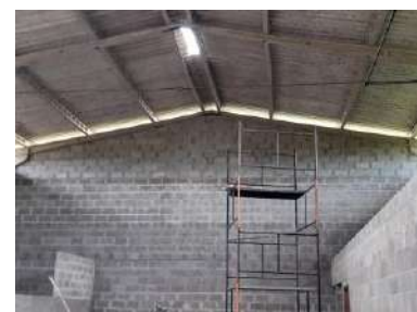
5. Demolição de estruturas danificadas e reconstrução de parede frontal (frente do terreno).
