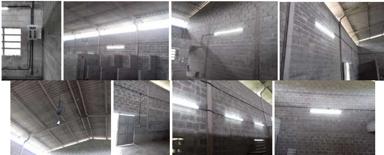
7. Instalação rede elétrica e iluminação.
