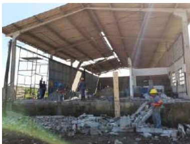
5. Demolição de estruturas danificadas e reconstrução de parede frontal (frente do terreno).
