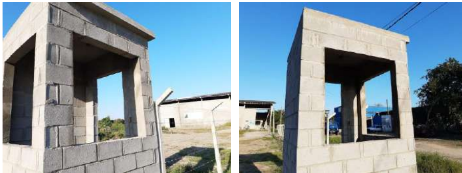
8. Construção de guarita.
