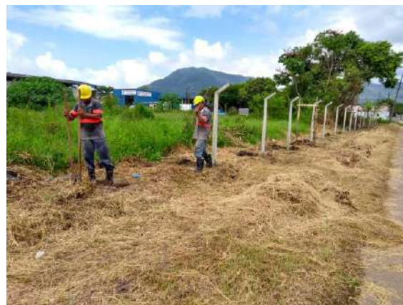
2. Instalação de cerca em uma face lateral e na face frontal.
